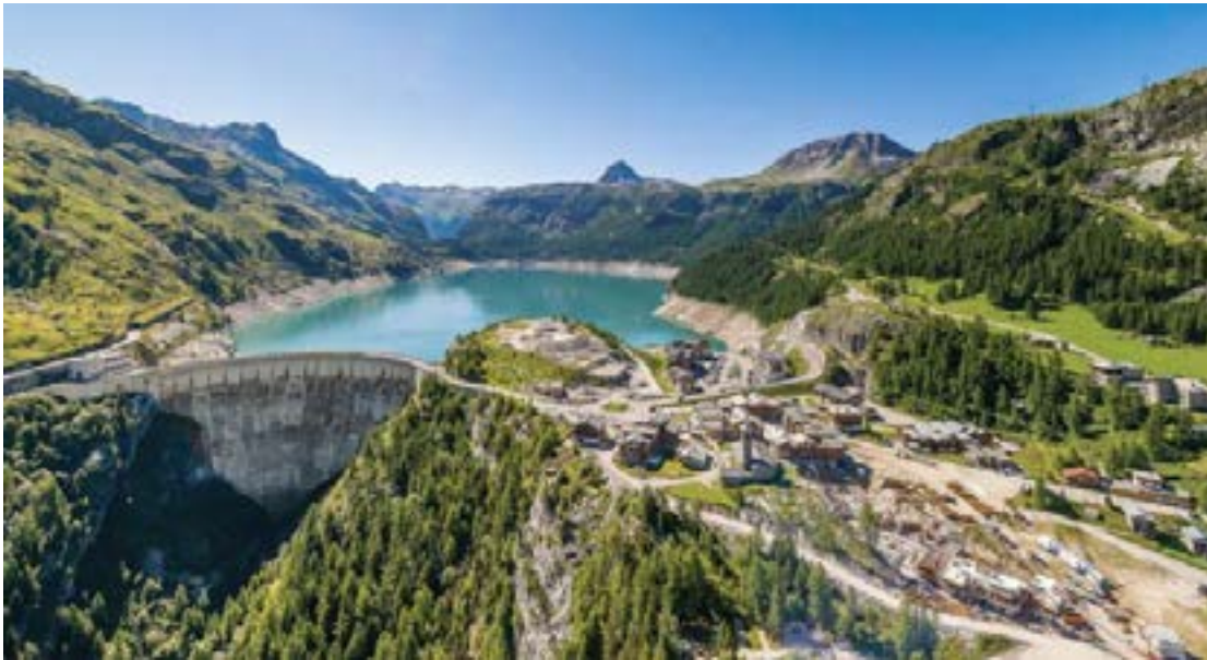
Hydro Barrage de Tignes © A. Parant
