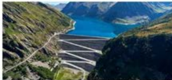
Le barrage de Grand'Maison est la centrale de pompage-turbinage la plus importante de France avec une puissance installée de 1 800 MW.
