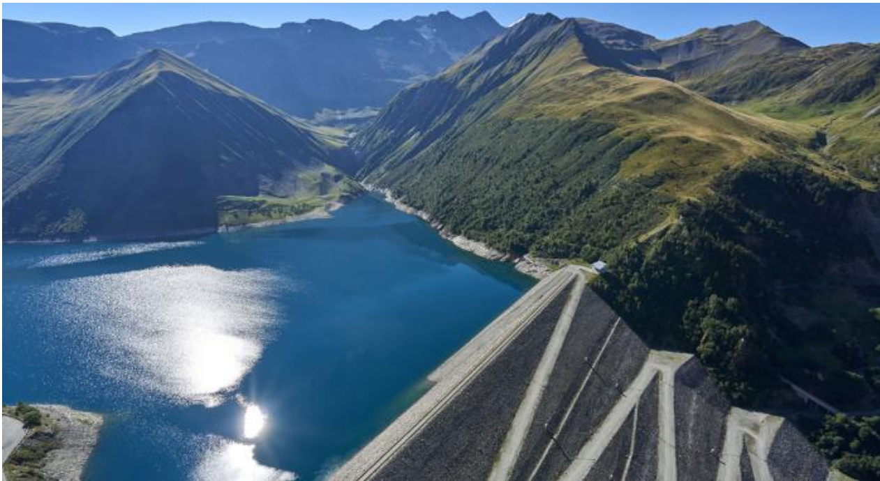
Le barrage de Grand-Maison dans l'Oisans ©EDF-D.Guillaudin
