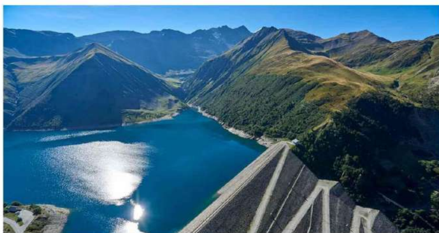
Le barrage de Grand'Maison, à Vaujany, est la centrale hydroélectrique la plus puissante de France.
