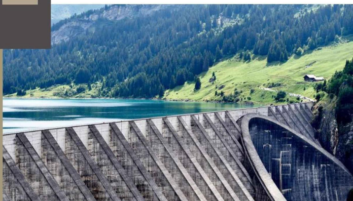
© Pxhere - La 10 e édition du salon Business Hydro à Alpexpo Grenoble, les 14 et 15 octobre.
